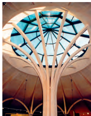
Tragwerk eines Möbelhauses, gefertigt von Fa. Gebr. Schütte KG, Flethsee (Foto: Fa. Schütte)
