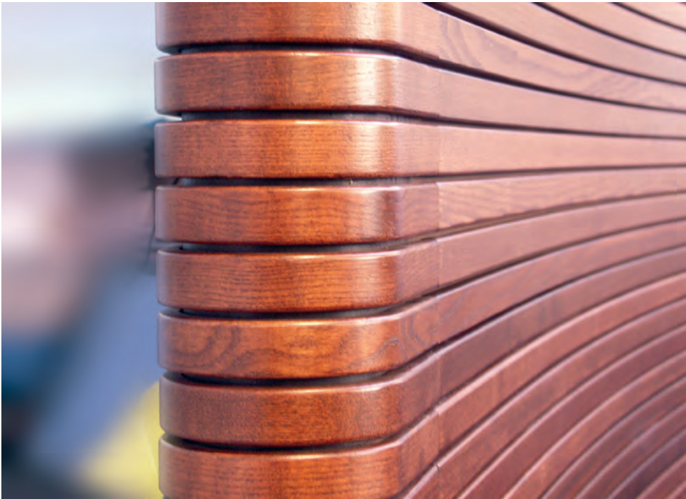
Trennwand aus gebogenem Eschenholz, gefertigt von Fa. Graf, Sulgen CH. (Foto: Fa. Graf)
