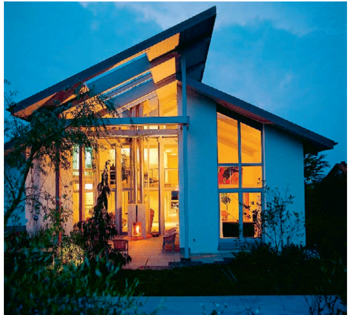
Die Dachform prägt den Charakter des Hauses ganz entscheidend, wobei der früher ungenutzte Dachboden weitgehend verschwunden ist.
