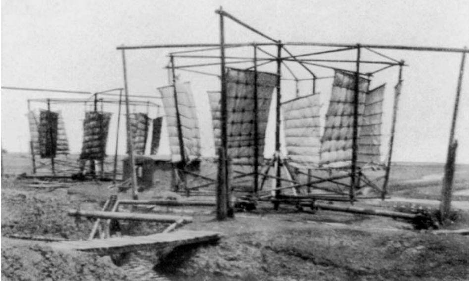
Bild 1.2: Chinesisches Windrad zum Wasserschöpfen (Foto Deutsches Museum)
