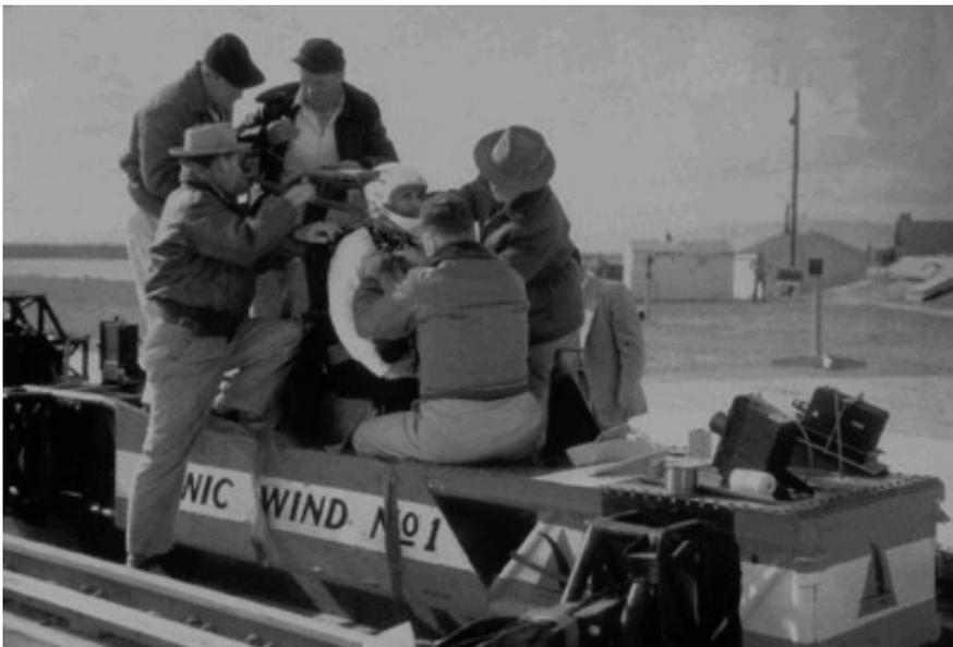
**Abb. 1.3** Colonel Stapp auf dem Raketen getriebenen Schlitten "Sonic Wind No. 1" sitzend, mit dem er sich einer Beschleunigung von 40g aussetzte [<http://www.stapp.org>].
