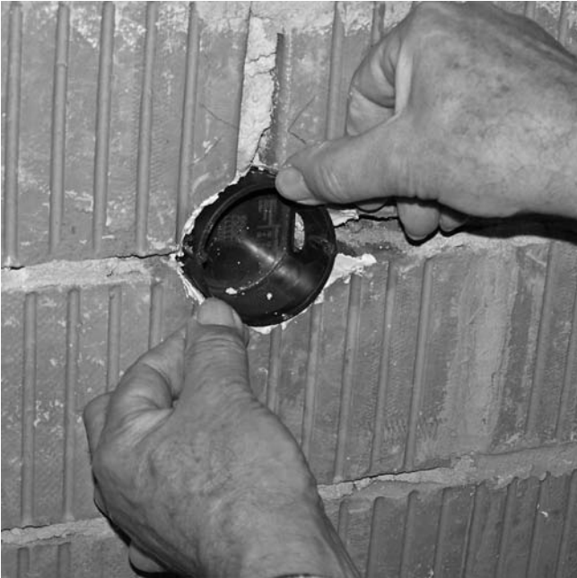
Abb. 6.13: Die Gerätedose wird anschließend in die Wand gedrückt und passgenau positioniert.
