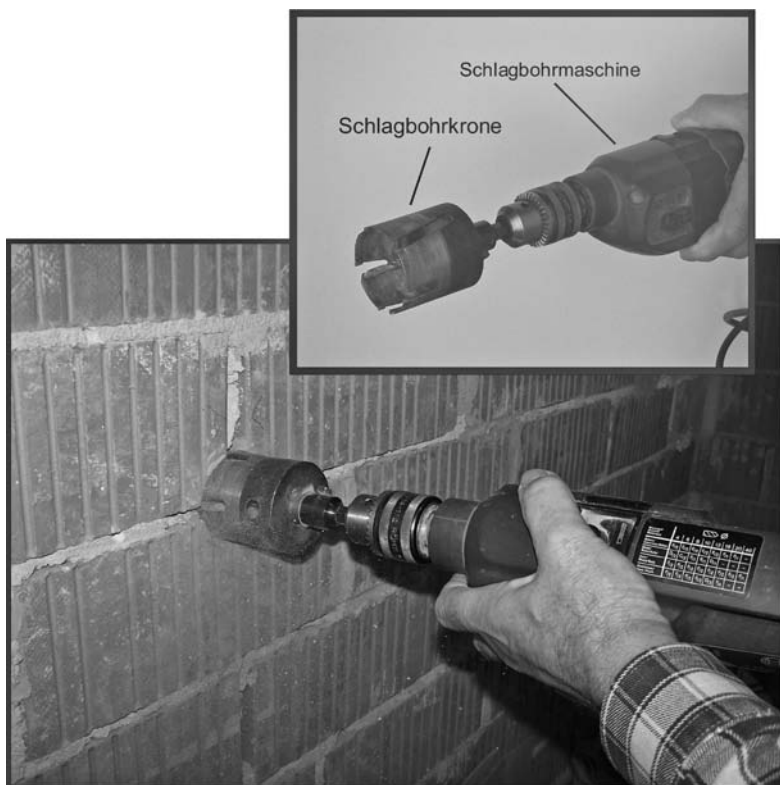
Abb. 6.5: Eine Schlagbohrkrone fräst das passende Loch aus dem Mauerwerk kreisförmig heraus.
