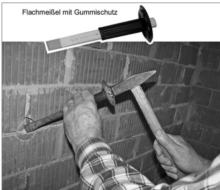
Abb. 6.8: Für das grobe Ausstemmen des Mauerwerks eignet sich am besten ein mittelgroßer Flachmeißel mit einem Gummischutz.
