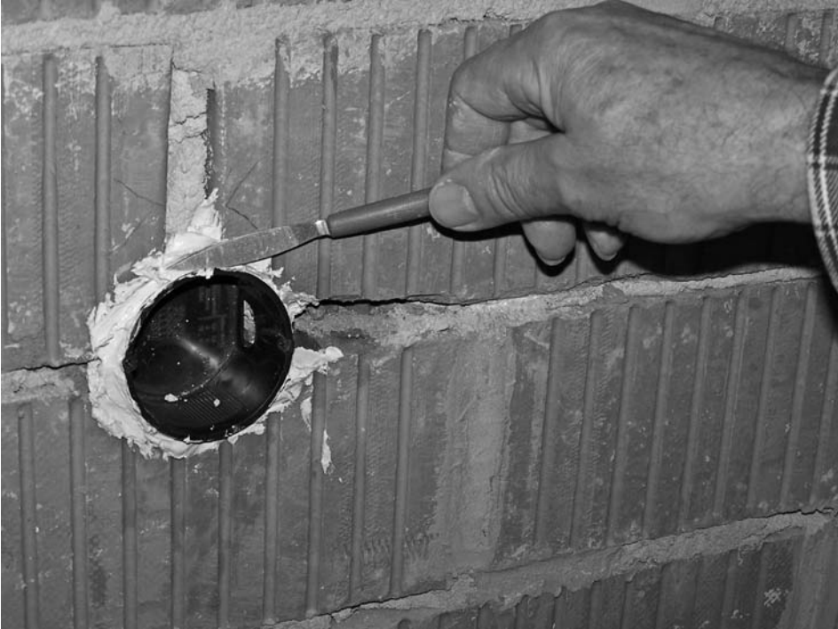
Abb. 6.14: Nachdem der Gips oder die Spachtelmasse hart geworden ist und der Gerätedose ausreichend festen Halt bietet, kann das Einputzen der Dose z. B. mit einem kleinen (Stukkateur-)Spachtel vervollständigt werden.
