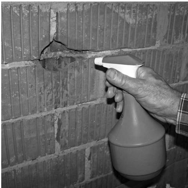
Abb. 6.11: Vor dem Eingipsen der Gerätedose sollte das Mauerwerk mit Wasser eingesprüht oder eingepinselt werden, damit sich der Gips besser mit dem Mauerwerk verbindet. Wird anstelle von Gips eine andere Spachtelmasse verwendet, entnehmen Sie der Bedienungsanleitung, ob diese Masse nicht ein trockenes (und staubfreies) Mauerwerk benötigt.
