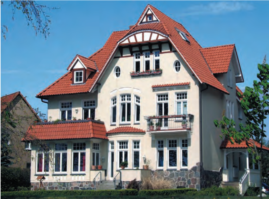
Abb. 1.1: Frisch renovierte Altbauvilla mit zahlreichen Vorsprüngen; diese machen zwar optisch Eindruck, jedoch geht über beheizte Anbauten im Vergleich zu einem kompakten, würfelförmigen Baukörper mehr Heizwärme verloren. (Quelle: BHW Bausparkasse)
