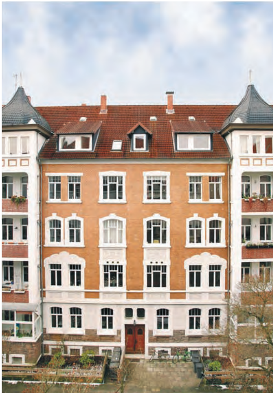
Abb. 1.5: Sanieretes Mehrfamilienhaus; viel Aufwand wurde betrieben, um die ursprüngliche Fassade zu erhalten. (Quelle: BHW Bausparkasse)
