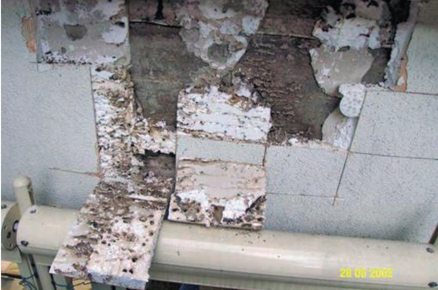
Abb. 8.6: Hier ist von der Dämmung nicht mehr viel übrig: von Insekten angefressenes Polystyrol.
