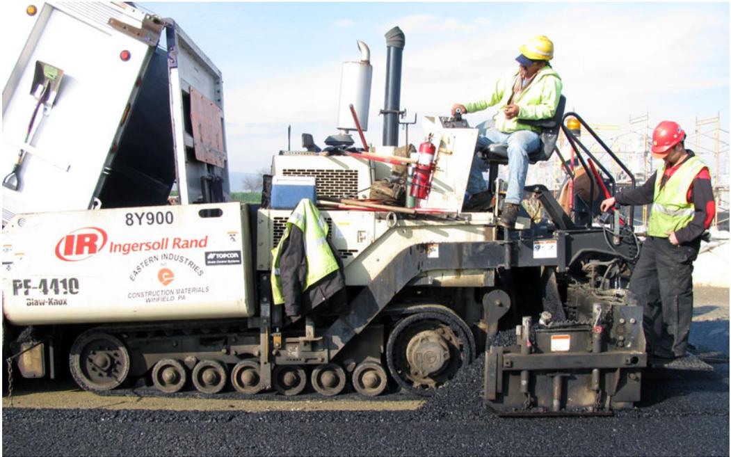
**Abb. 1.11** Parkplatzbau mit Vibrationsbohle: Eigenaufnahme, 2010
