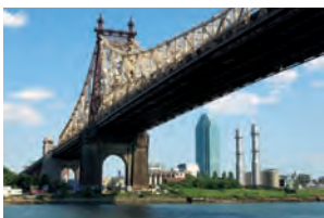
Long Island y el característico edificio del Citicorp, en el distrito de Queens.
