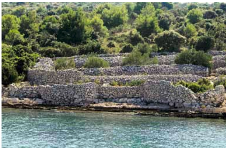
In mühsamer Handarbeit wurden die langen Steinmauern aufgeschichtet.
