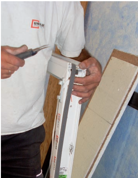
Abb. 1.14: Komprimierband zur Abdichtung des Fensterrahmens.
