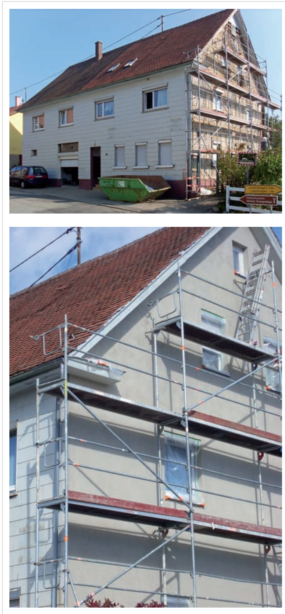
Abb. 1.1: Haus bei der energetischen Sanierung.
