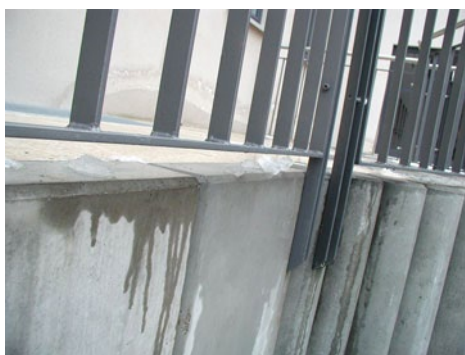
Abb. 2.1.2-4 Unkontrolliertes Wasserablaufen
