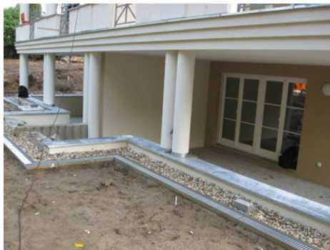
Abb. 2.1.3-8 Schlagregen, ggf. „Rückstau“
