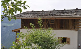
86 Liebe zur Tradition Restaurierung eines solitären Bauernhauses bei Bozen
