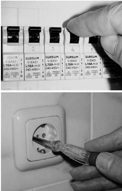
Abb. 2: Wenn sich ein elektronisches Gerät „tot stellt“, liegt es sehr oft daran, dass entweder sein Stecker nicht in der Steckdose steckt oder dass z. B. der Sicherungsautomat den Strom abgeschaltet hat.
