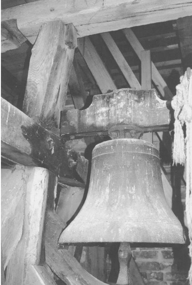
Glockenstuhl, laut Balkeneinritzung um 1610 errichtet
